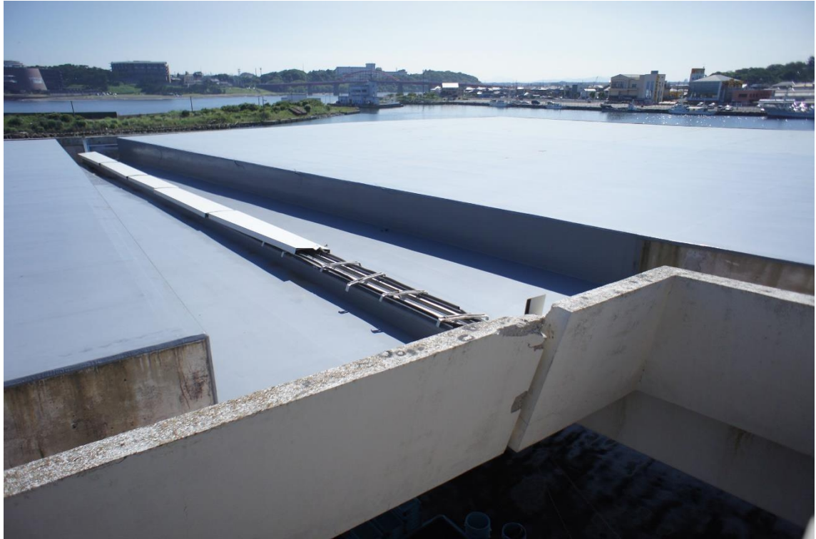
市場屋上 【整備前】
