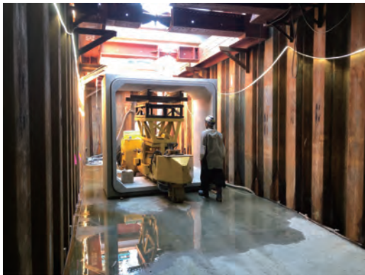
高場雨水2号幹線【ハイパーリフト工法の施工の様子】
