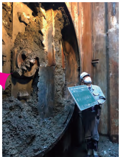
【雨水管（φ2000）の到達の様子】
