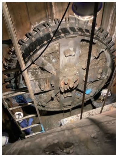
【雨水管（φ2000）の到達の様子】
