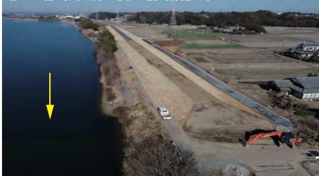
② R 4 那珂川左岸三反田地区築堤工事
