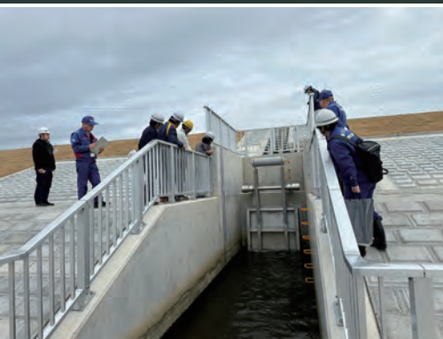
百色山排水樋管
