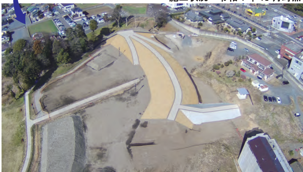
工事完了 令和5年2月時点
