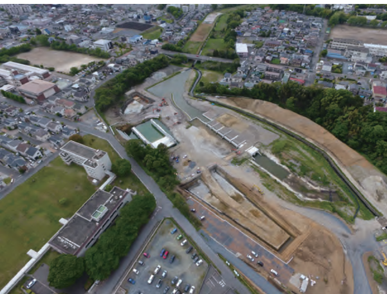
施工状況 令和4年5月時点
