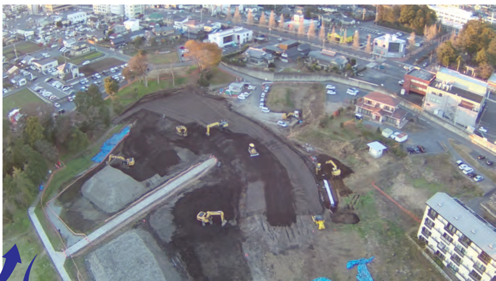
施工状況 令和4年12月時点
