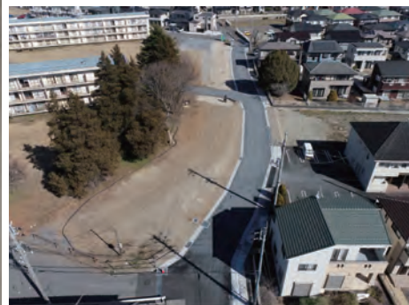
高場雨水1号幹線管きよ布設工事 高場雨水1号幹線管きよ布設工事
