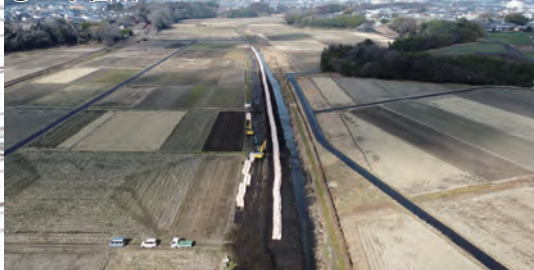
施工状況 令和5年3月時点
