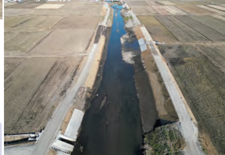
施工状況 令和5年3月時点
