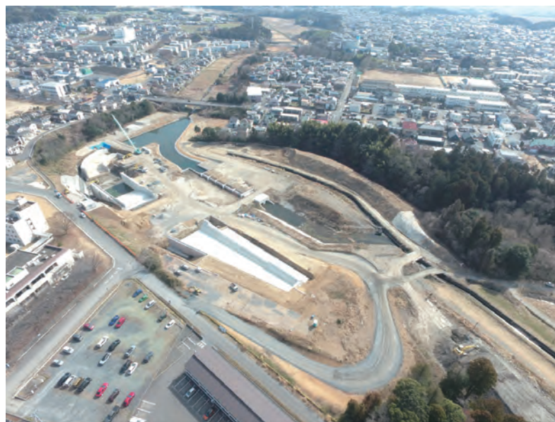
施工状況 令和5年3月時点
