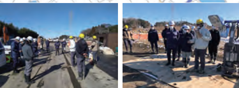
▲上の写真は、左から工事概要説明、地盤改良工の説明
