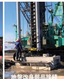
地盤改良部品接続
