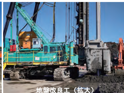
地盤改良工（拡大）
