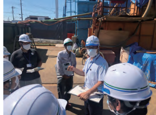
▲上の写真は、若手職員に平野主幹が工事について説明をしています。▼下の図面は今回の研修資料です。
