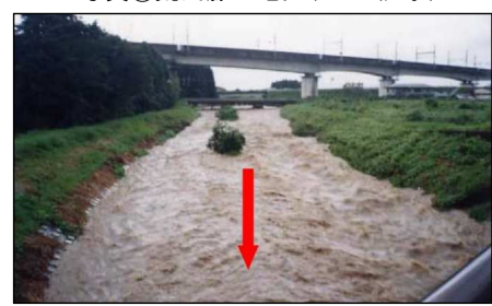
写真②熊川旭橋付近（H10.8洪水）
