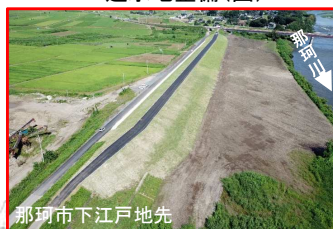
堤防整備事例(国)
