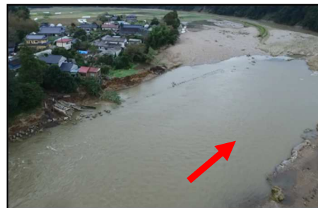
写真①荒川藤田地区（R1.10洪水）
