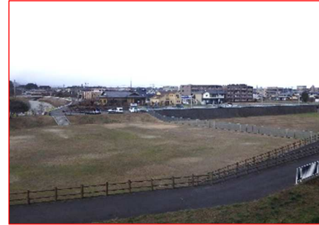
調整池の整備事例（那須塩原市）
