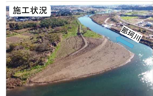
(令和2年11月撮影(河道掘削完了))
