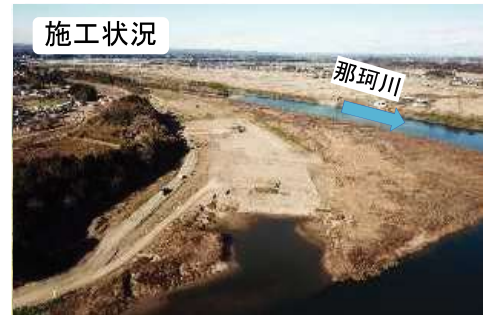
(令和2年12月撮影(河道掘削中))
