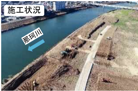
(令和2年12月撮影(河道掘削中))
