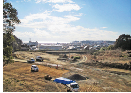
整備が進む土地区画整理事業 (船窪地区)
